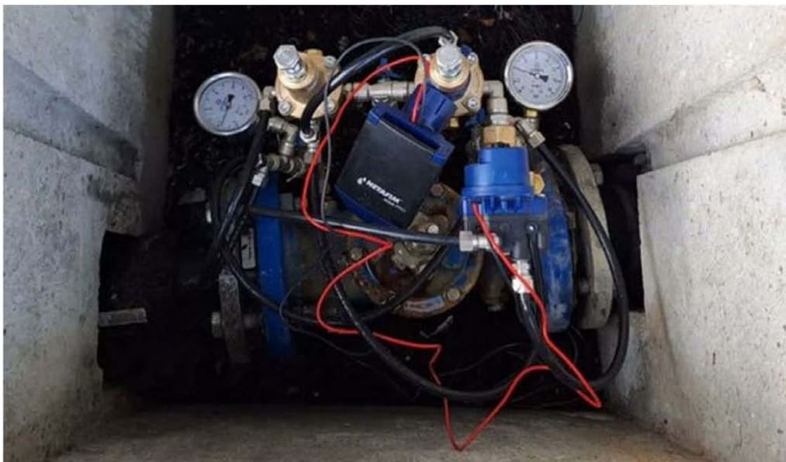
Se están instalando contadores inteligentes y sistemas de reducción de la presión en la red municipal de agua.
