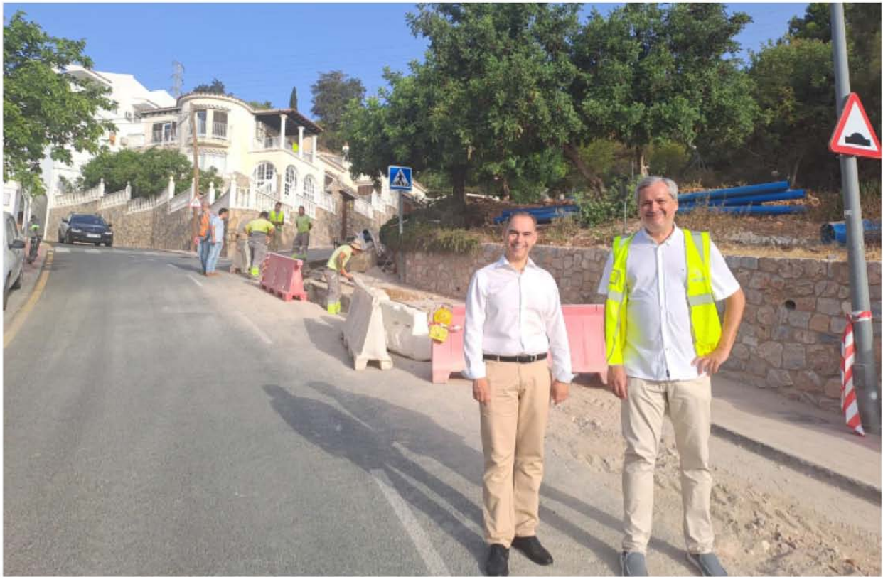
Visita del alcalde y el gerente de Emabesa a la zona donde se realizan los trabajos. SUR
