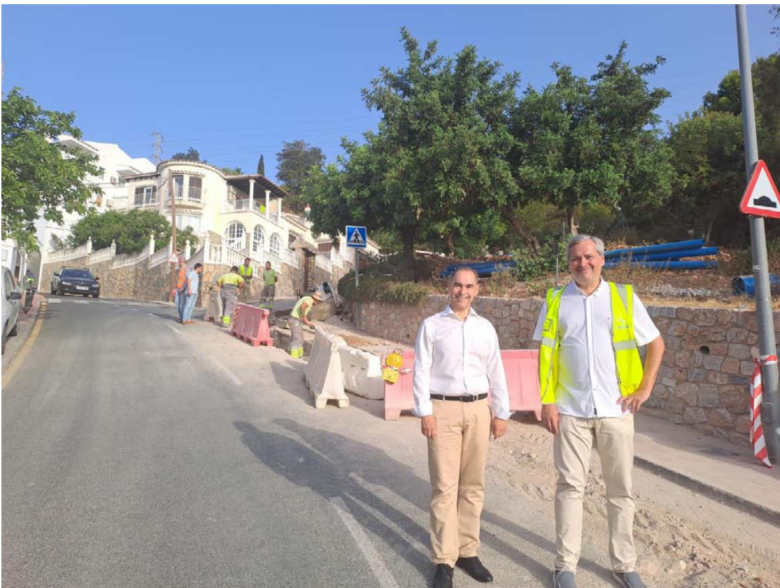
Visita a los trabajos. - VB
